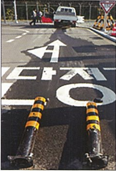
터파기 없이 설치, 기초가 약해 작은 충격 에도 파손된 철제 볼라드
